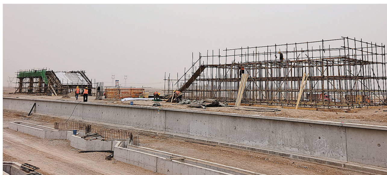
包银高铁银巴支线巴彦浩特站建设现场 侍新元摄
